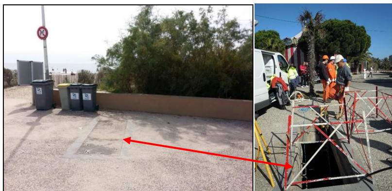
Figure 10 : Vues extérieures d'une chambre-plage : fermée et ouverte (setec in vivo)
