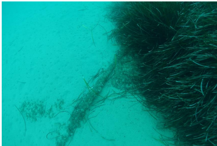
Figure 74 : Câble télécom en sortie d'herbier en limite supérieure (Marseille, 2020)
