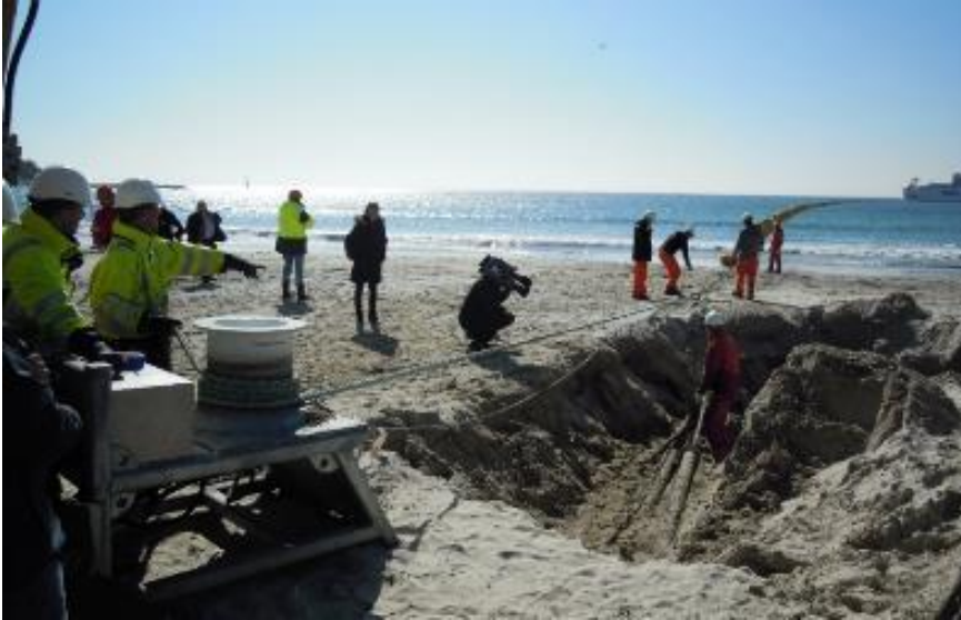
Figure 27: Opération de tirage du câble à terre avec un cabestan hydraulique
