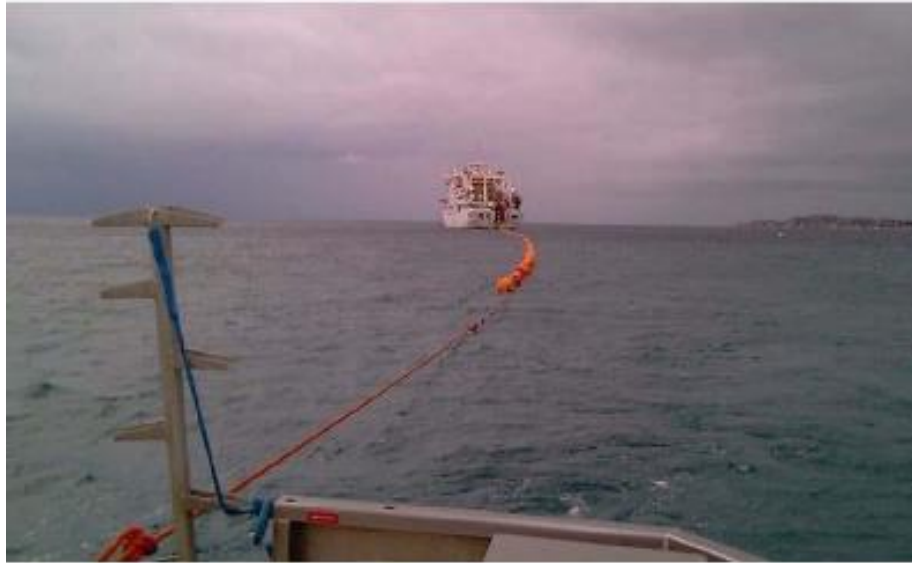
Figure 23 : Exemple de tirage d'un câble depuis un navire câblé vers la plage (source : Orange Marine)
