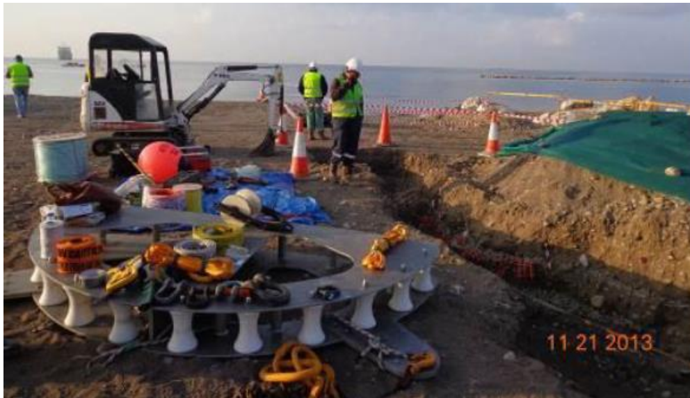
Figure 25 : Vue d'un quadrant (source : Orange Marine)
