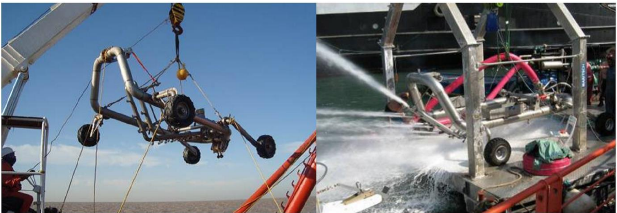
Figure 31 : Trencher de type « jet sledge » permettant l'ensouillage des câbles (Orange Marine)
