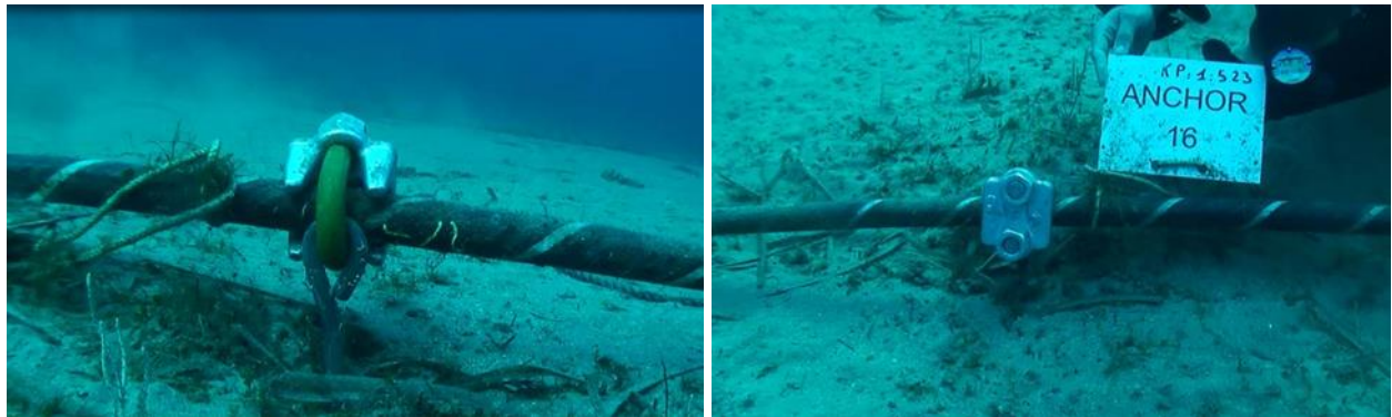
Figure 35 : Autre système de fixation du câble à l'ancre visant à limiter le risque de croche de l'ancre dans les filets de pêche (Orange Marine)
