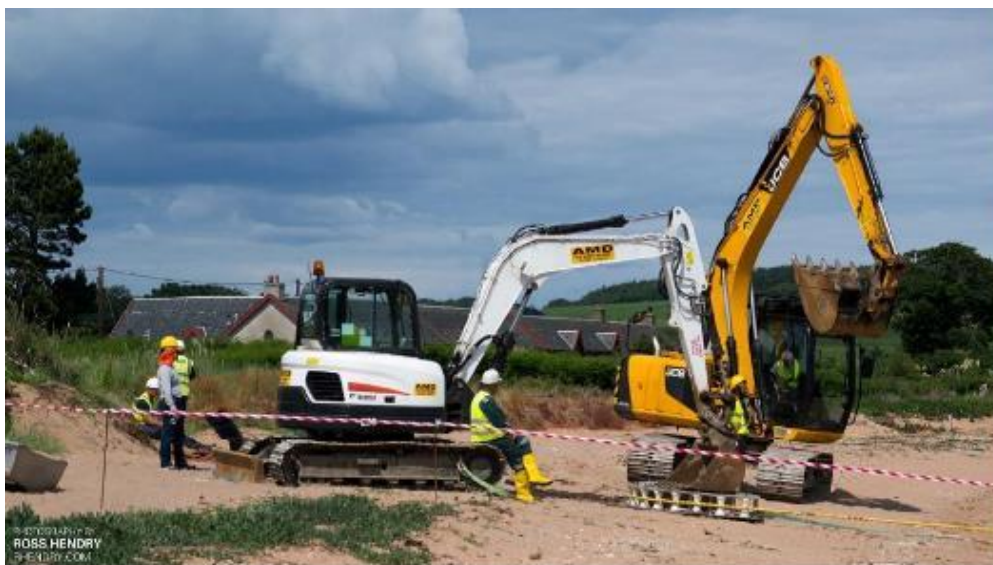
Figure 24 : Opération de tirage de câble avec deux pelleteuses et un quadrant (source : Orange Marine)
