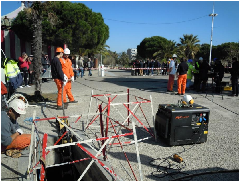
Figure 28 : Tirage du câble en dehors de la chambre-plage avant raccordement
