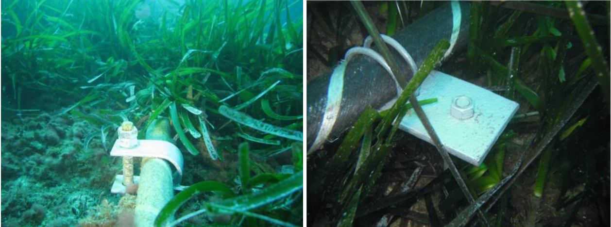
Figure 34 : Deux systèmes de fixation d'ancres à vis installées en zone d'herbier (photo : setec in vivo)
